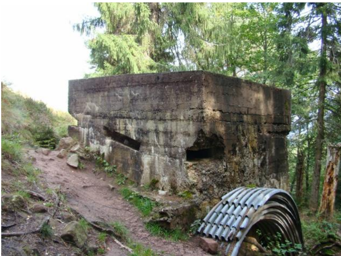
Een Duitse bunker op de helling van de Lingekopf met schuin omhoog lopende schietgaten.
